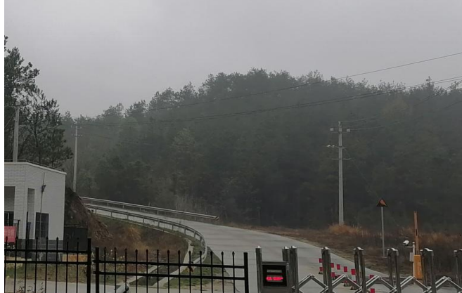
进场硬化道路
