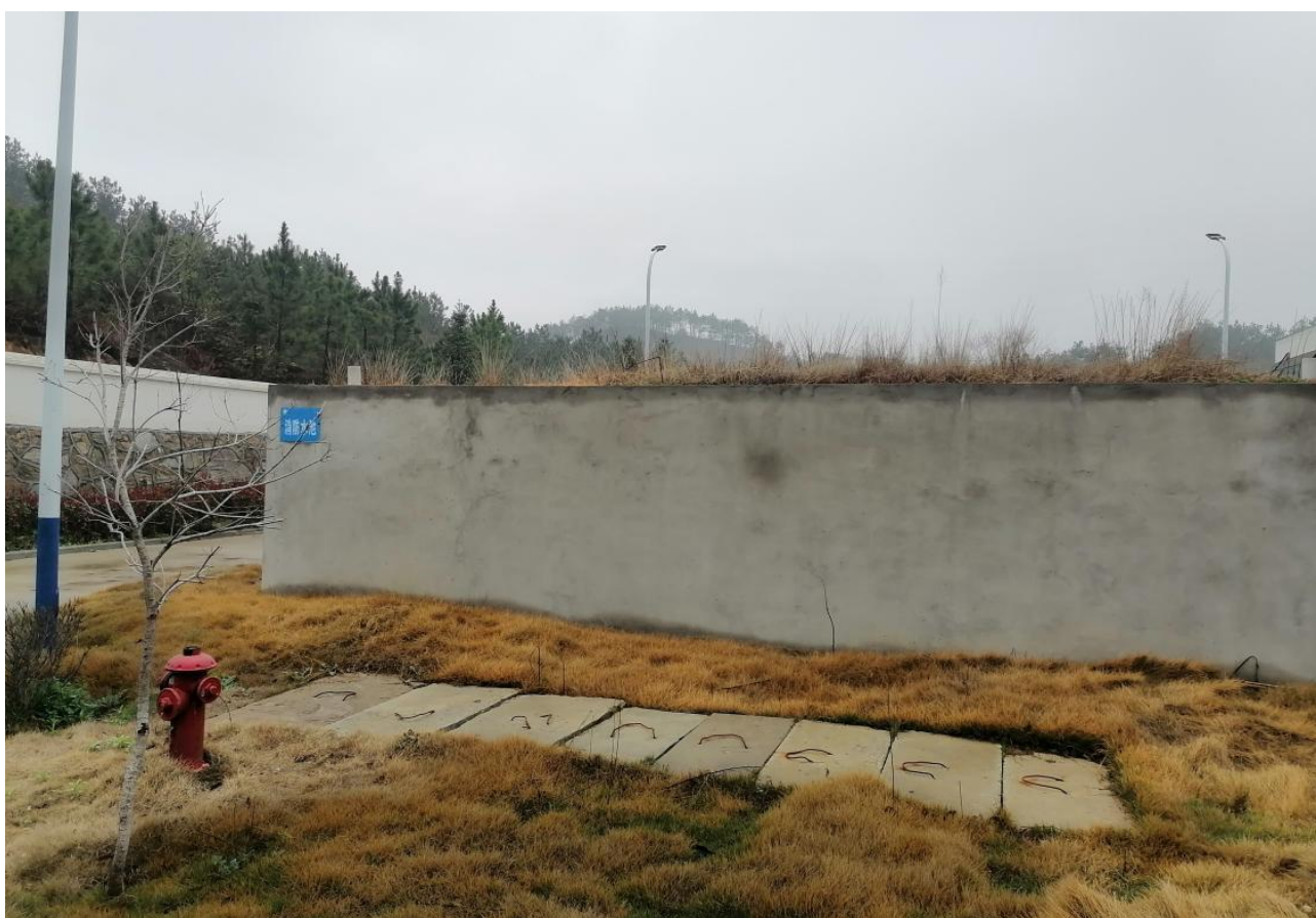
消防水池及消防栓
